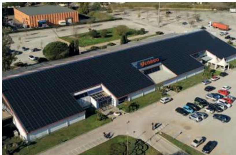
L'IMPIANTO FOTOVOLTAICO DA 400 KW DI UNIEURO ROMA REALIZZATO DA RESIT
