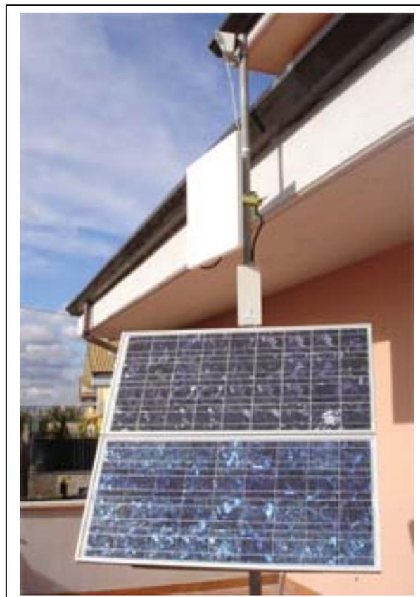
Il dimensionamento di progetto consente prestazioni di videosorveglianza fino a 24 ore al giorno continuative (in condizioni di luce sufficienti), con trasmissione dati periodica (immagini e dati) grazie al sistema di storage, con batteria di accumulo per garantire circa 6 ore/giorno di trasmissione dati anche in caso di mancanza di sole (per es. per pioggia) per circa tre giorni.
